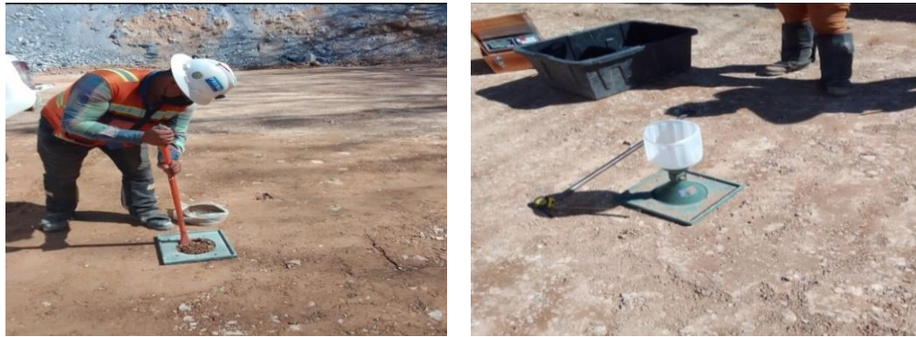
Figura. 16 Colocación de cono sobre placa
