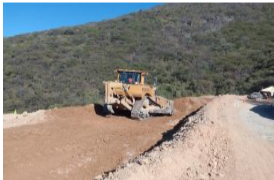
Figura.9 – trabajos de descarga y tendido de capa
