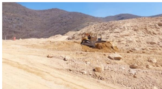
Figura.6 –Cortes y extracción de material de banco
