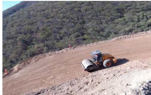
Figura.11– Compactación con Vibro compactador.
