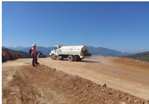
Figura.10 – Riego de Liga Sobre Plataformas
