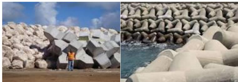
Figura 2: Elementos prefabricados para rompeolas.
