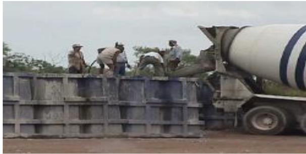
Figura 7: Fabricación de los cubos.
