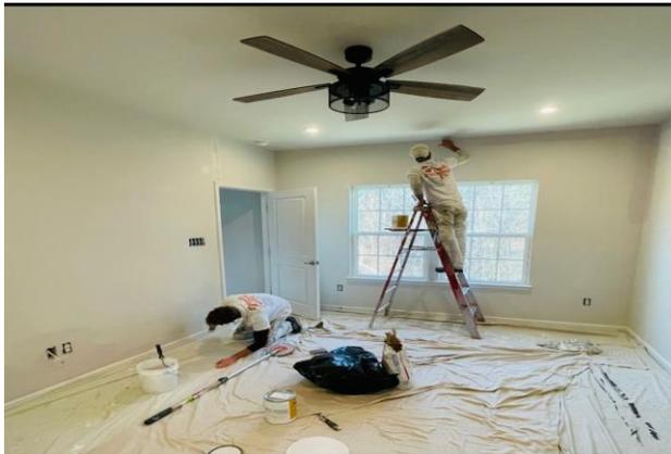
**Fig.4** En pintura lo primero es poner una manda en el piso para no manchar la cerámica o piso de madera, después se procede con el margen, ya sea porque el cielo es de diferente color y la pared de un color distinto, en la pintura realmente no hay mucha diferencia entre México y Estados unidos ya que son los mismos procedimientos que se maneja en la compañía.
