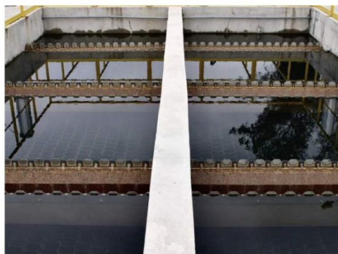
Figura 8. Unidad de sedimentación (Díaz, 2021).
