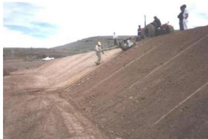
Fig. 8 - Compactación de taludes
