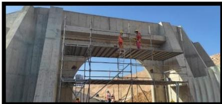
FOTO 8.0.-COLOCACIÓN DE PLACAS METÁLICAS, EMBEBIDOS AL CONCRETO
