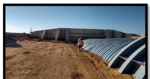
FOTOS. -RELLENO Y COMPACTACIÓN HASTA EL NIVEL DEL TERRENO NATURAL (NTN)
