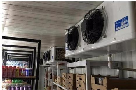
**Figura 19. Instalación y pruebas del equipo de enfriamiento para el cuarto frío.**
