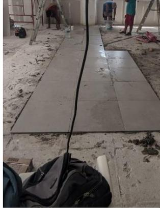
**Figura 2.- Instalaciones eléctricas en cimentación para contactos en suelo.** Fuente: elaboración propia
