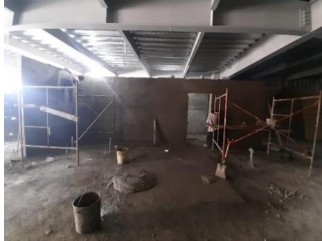
**Figura 4.- Aplanado de muros con mortero.** Fuente: elaboración propia
