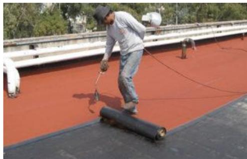
**Figura 5.- Colocación de impermeabilizante color terracota.** Fuente: Ejemplo tomado de Google.
