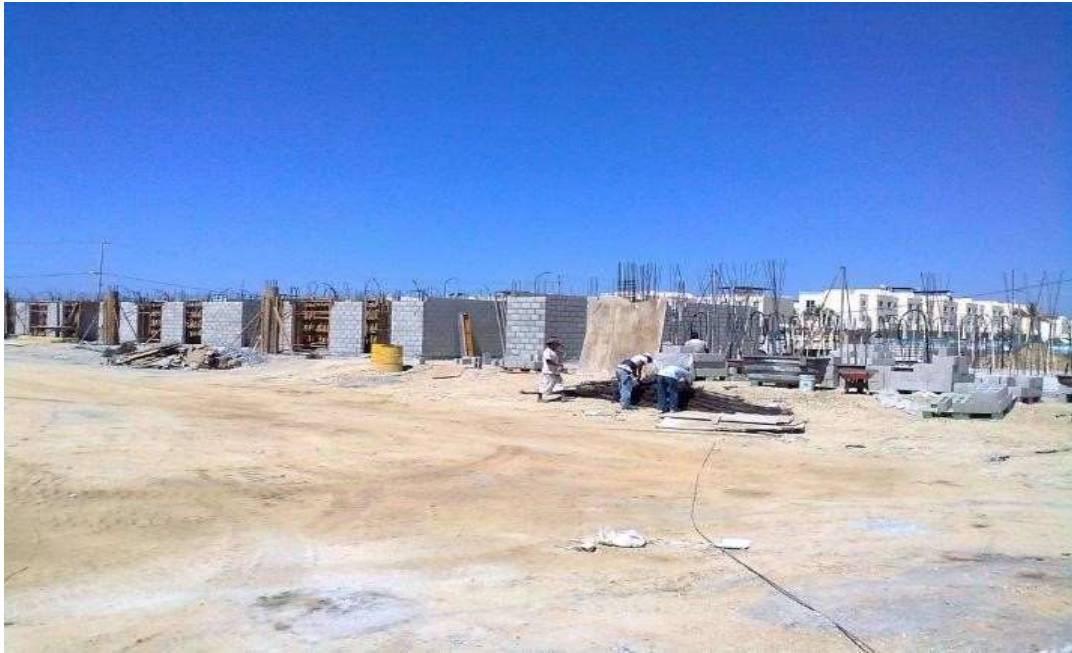
figura 2.2 Avance de construcción de fraccionamientos diamante fuente: Cortesía GEO (GUERRERO)
