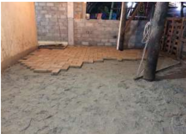
Fotografía 21: Colocación de tabique cocido en piso de planta baja.
