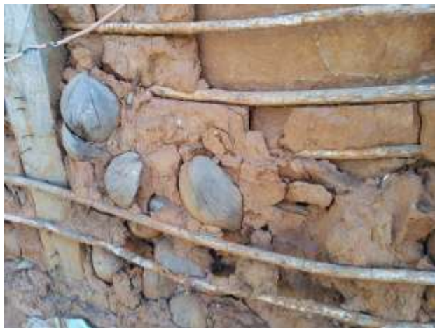
Fotografía 1: Mezcla de lodo, con conchas secas de coco y varas de madera para conformar paredes de recursos naturales.
