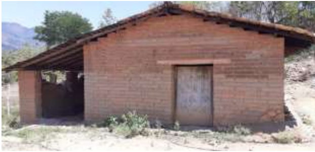
Fotografía 4: Casa de bloques de tabique con barro, en Marquelia.
