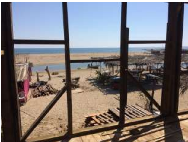
Fotografía 22: Base para ventanas con vista a la mar.
