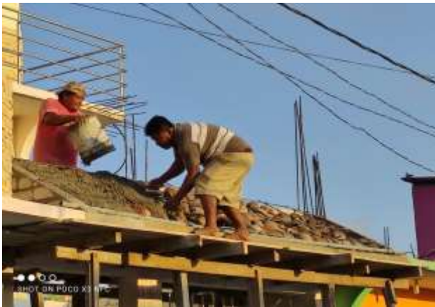
Fotografía 14: Colocación de mezcla de concreto y bonote de coco en una fachada, en Marquelia.
