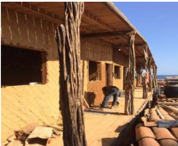
Fotografía 19: Paredes exteriores con varas de árboles recubiertas con barro.
