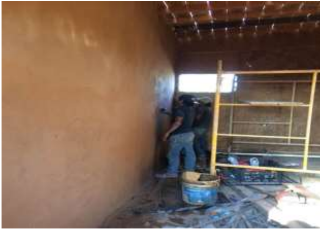
Fotografía 20: Revocado de paredes con barro.
