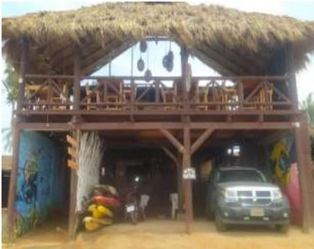
Fotografía 16: Vista al frente del eco hotel.
