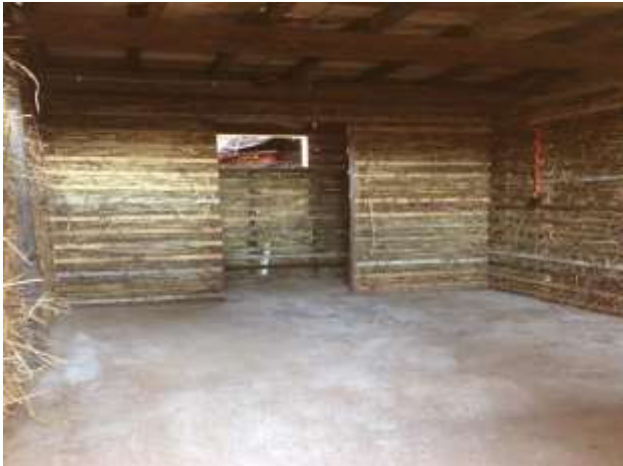
Fotografía 18: Interiores rellanados madera de palmeras y paja, para posteriormente, revocarla con barro.
