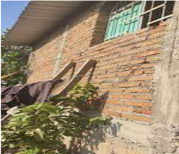
Fotografía 6: Pared de tabique cocido, en una vivienda.
