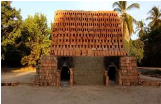
Fotografía 11: Horno tradicional de elaboración de tabiques en el municipio de Marquelia, Guerrero.
