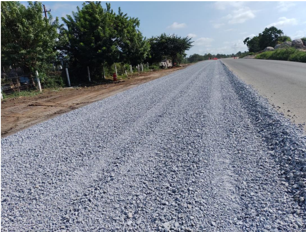
Figura 1.8. Tendido de material para base hidráulica
