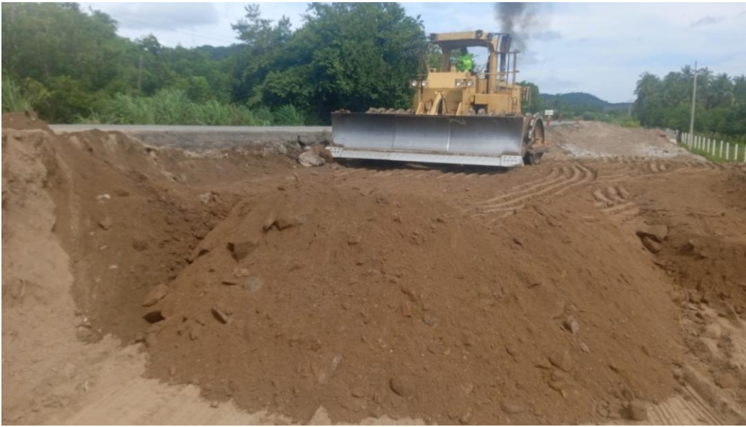
Figura 1.5. Compactación de Terraplén
