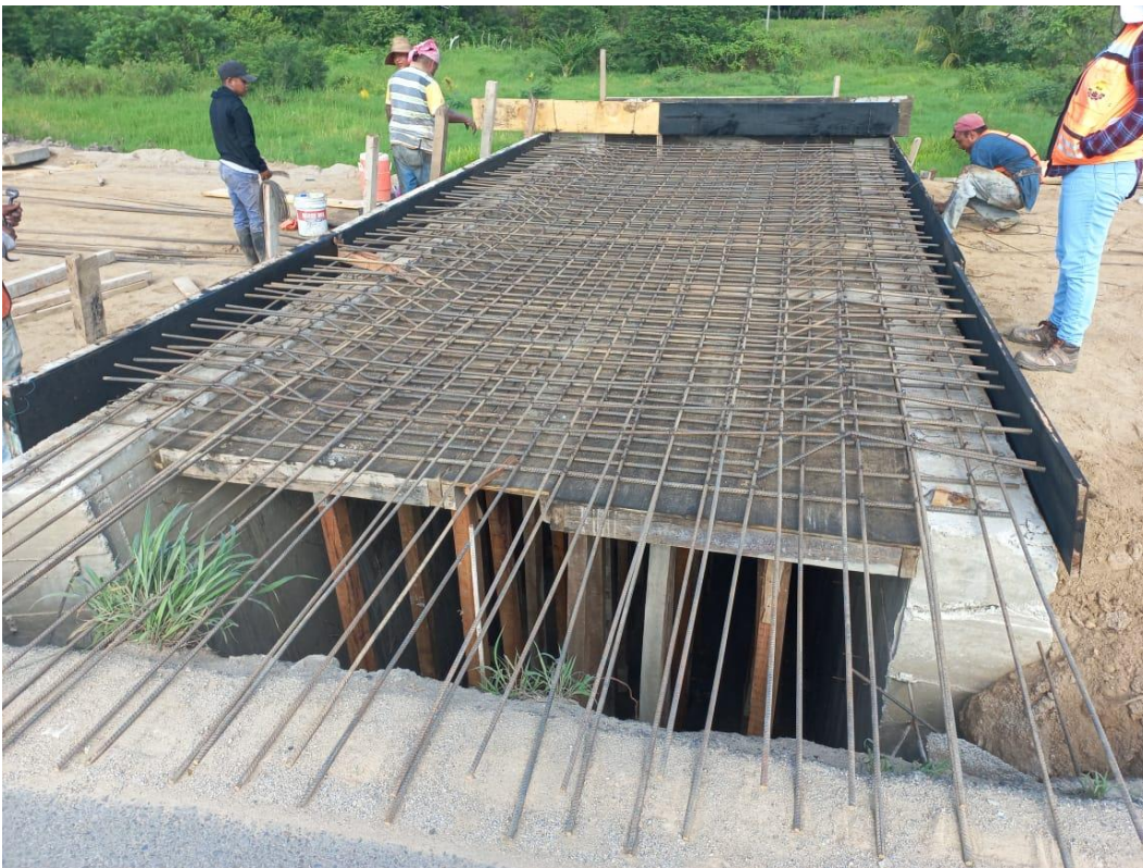
Figura 1.4. Armado de acero para losa de obras de drenaje
