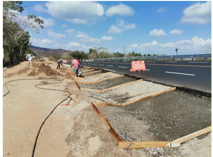
Figura 10: Construcción de Cunetas
