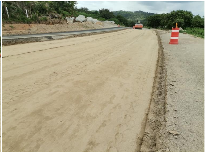
Figura 6 Compactación de la capa subrasante
