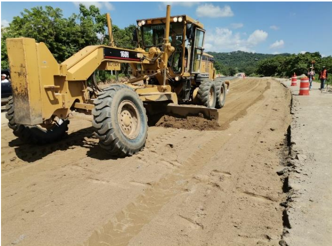
Figura 5: Tendido de la capa subyacente
