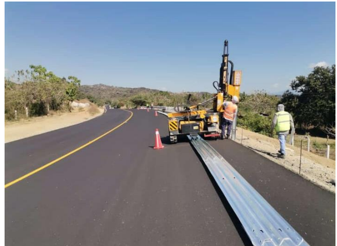
Figura 12: Colocación de barrera metálica
