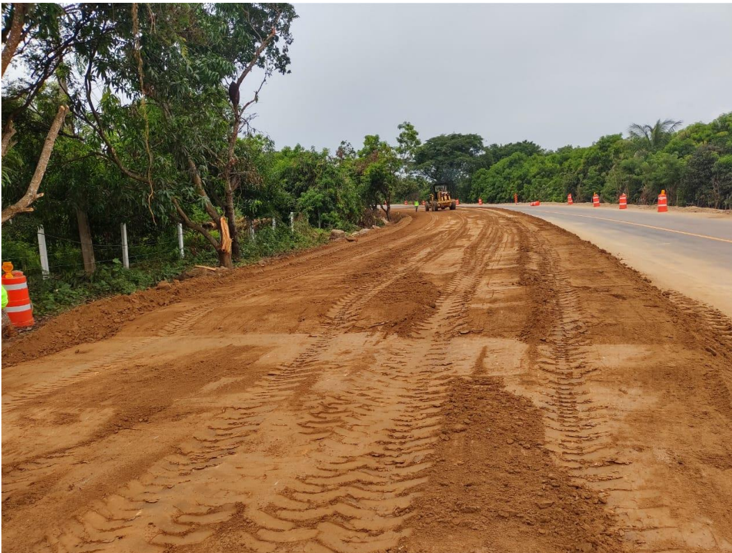
Figura 1.6. material capa Subrasante
