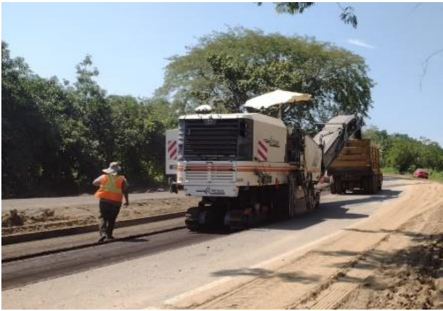
Figura 1: Recuperación de material de Carpeta Asfáltica existente
