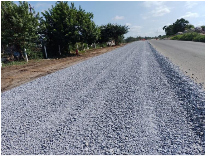
Figura 7: Tendido de Grava para Base Hidráulica.
