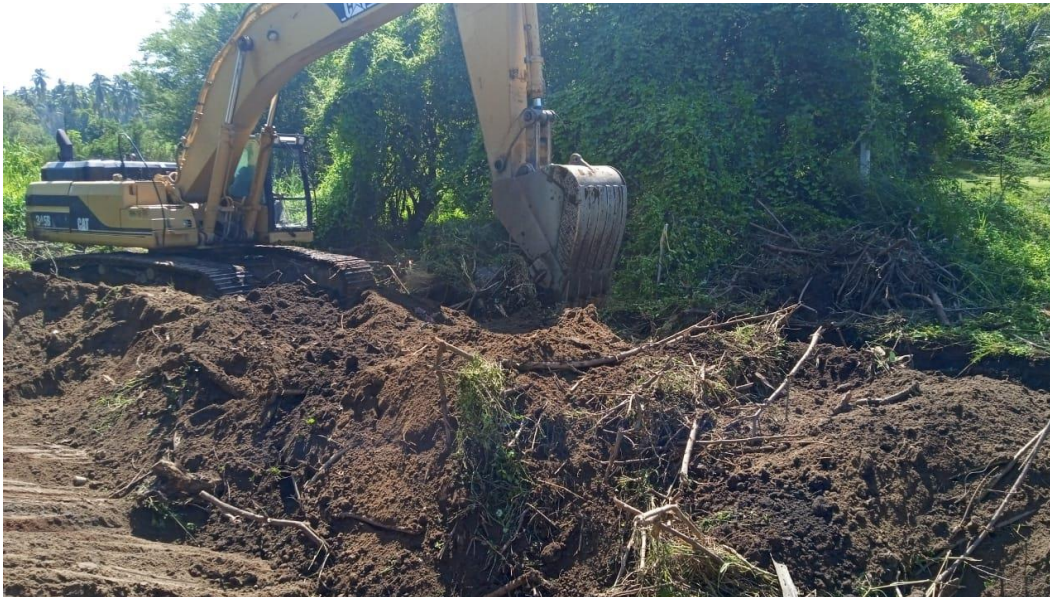
figura 1.2. Desenraice y Despalme
