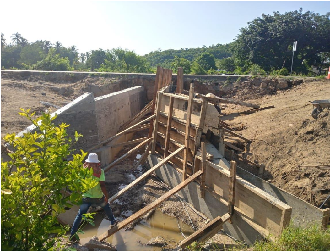
figura 1.3. Construcción de obras de drenaje
