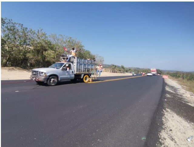
Figura 11: Aplicación de pintura para las líneas divisorias de los carriles.
