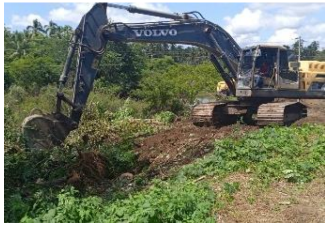
Figura 2: Despalle y desenraice de vegetación
