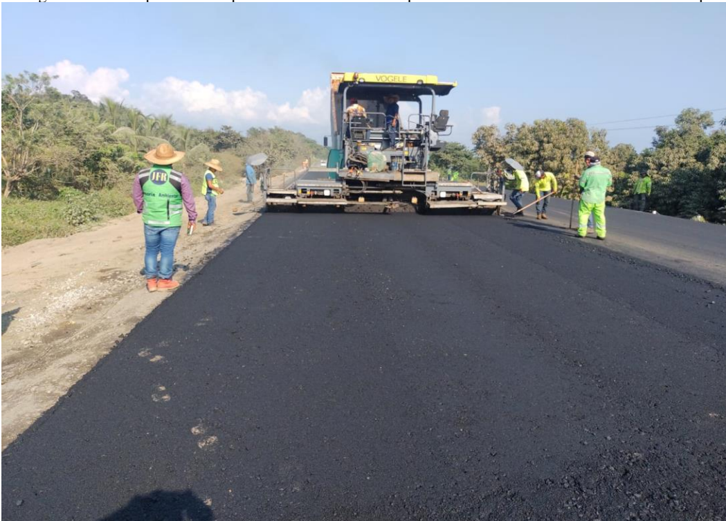
Figura 1.10. Tendido de carpeta asfáltica
