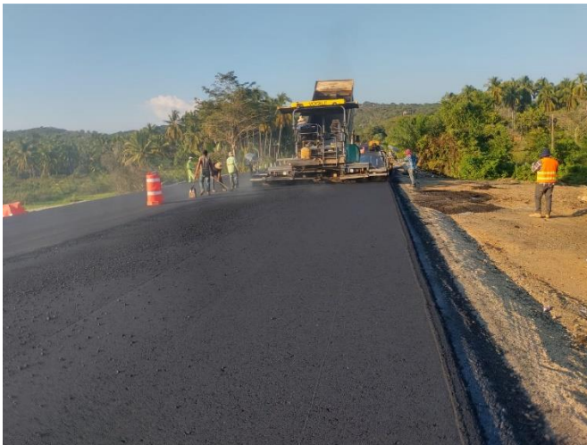
Figura 9: Tendido de Carpeta Asfáltica
