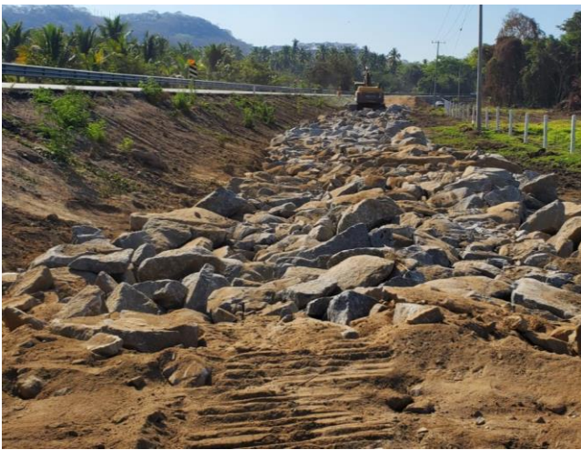
Figura 3: Capa de pedraplén en zonas necesarias
