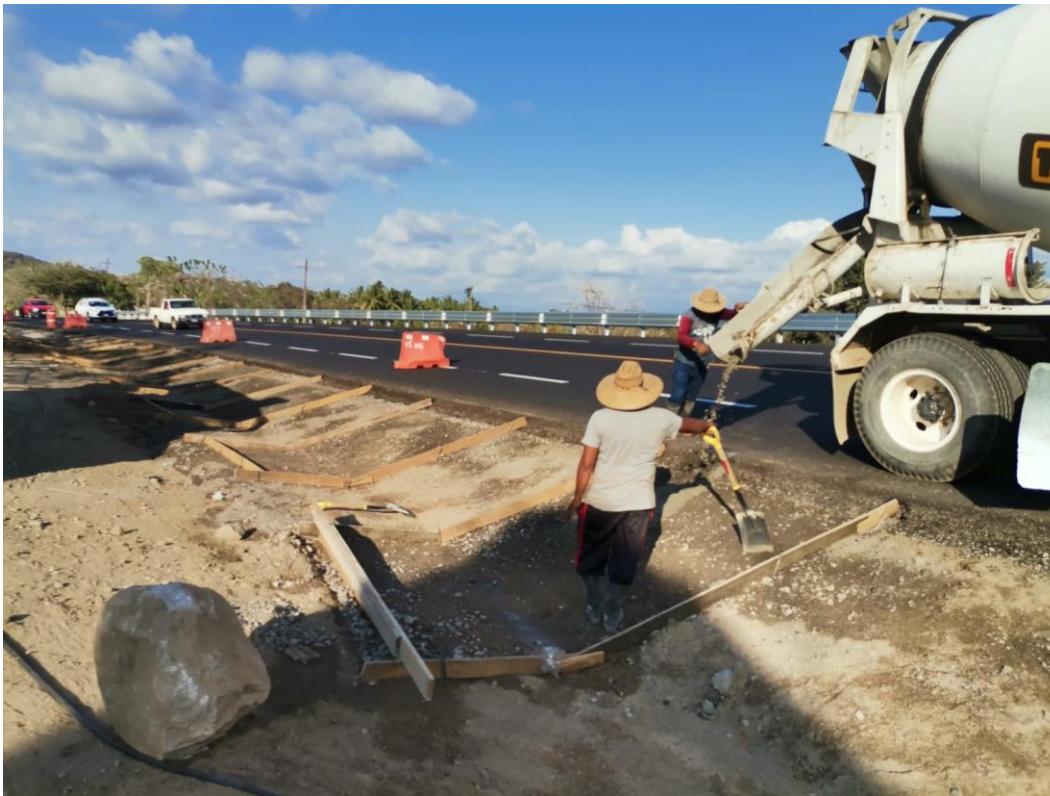
Figura 1.7. Construcción de Cunetas
