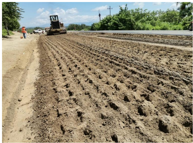
Figura 4: Compactación de la capa Terraplén.
