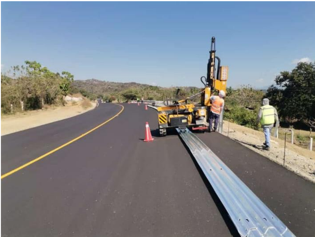
Figura 1.11. Colocación de barrera metálica
