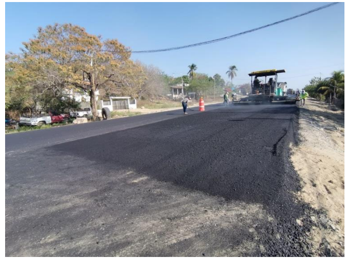
Figura 8: Tendido de Base Asfáltica.
