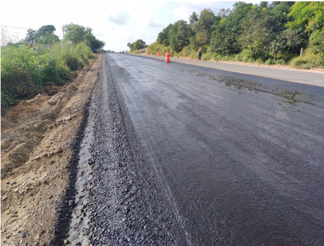
Figura 1.9. Riego de Impregnación
