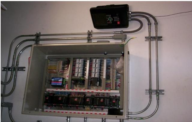
a) Controlador Danfoss Ak Sm 880 utilizado en automatización de instalaciones.
