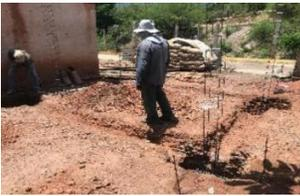
Figura 8 y 9. Excavación a mano en terreno tipo "b" investigado en obra.
