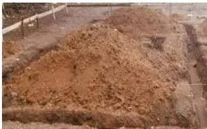
Figura 14. Relleno y compactación de material producto de excavación.
