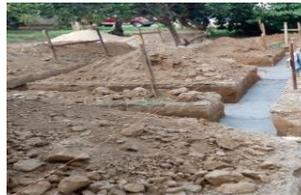
Figura 10. Plantilla de concreto un  $f' = 100 \text{kg}/\text{cm}^2$  de 5 cm de espesor.
