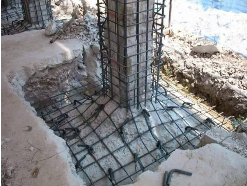
Fig.1.5.-Encamisados en columnas
