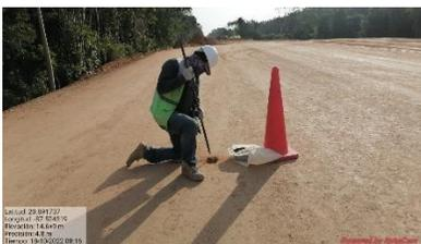
*Imagen 22 apertura de la capa mediante cala*
