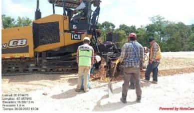
*Imagen 7 toma de muestra en tramo de capa existente.*
