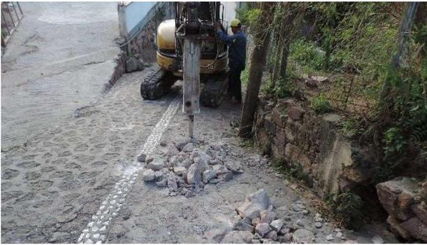
**Figura 3. Demolición de empedrado** (Fuente: elaboración propia)
