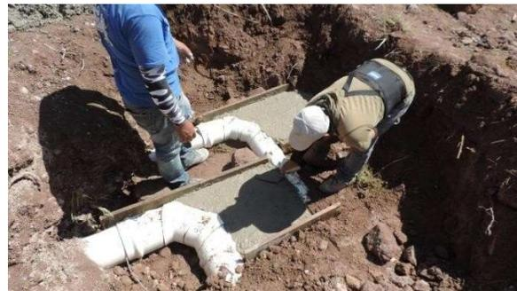
**Figura 6. Elaboración de soporte en tubería** (Fuente: elaboración propia)
