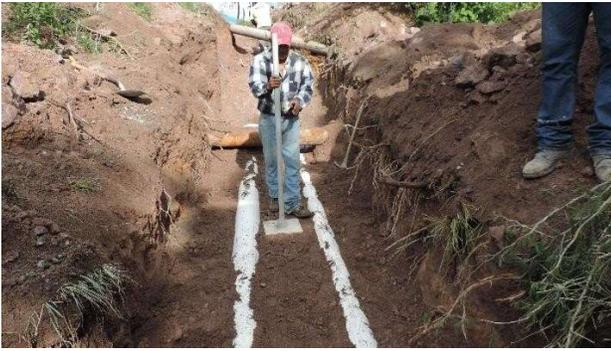
**Figura 7. Relleno y compactación en zanjas** (Fuente: elaboración propia)
