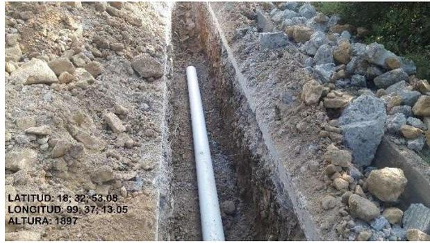
**Figura 4. Colocación de tubería PVC** (Fuente: elaboración propia)
