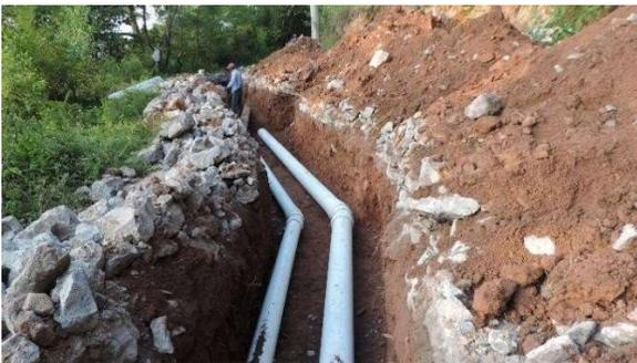
**Figura 5. Colocación de tubería PVC** (Fuente: elaboración propia)
