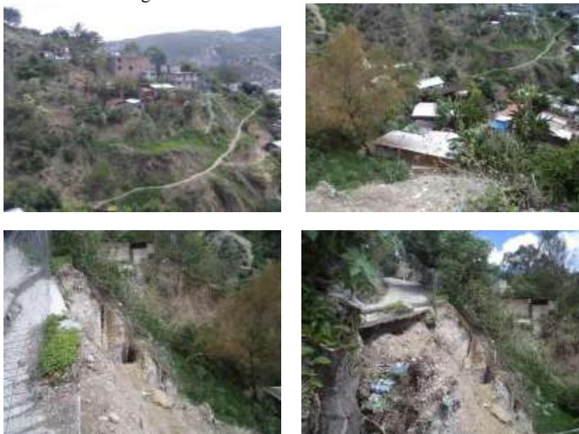
**Figura 6.- a. Construcciones ubicadas en taludes con alto riesgo de deslizamiento. b. Casas de láminas y madera, ubicadas en la ladera de la barranca. c. Deslizamiento en el talud. d. Deslizamiento en el cuerpo del talud, observando que en la cima del talud es una calle.**
