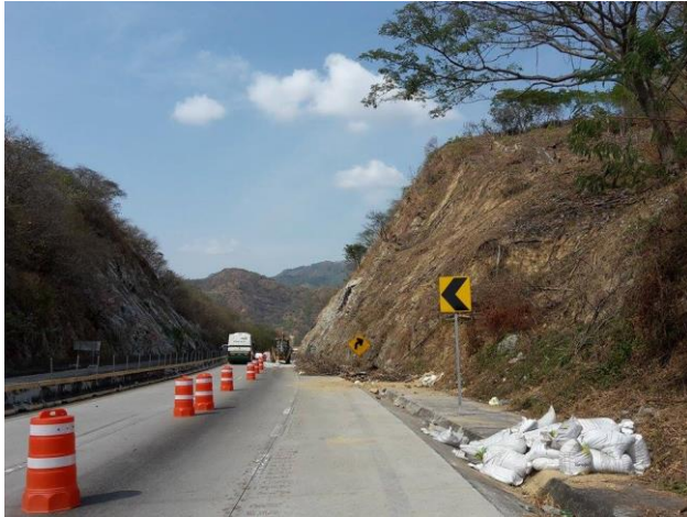
Figura 2. Señalamiento de obra.
