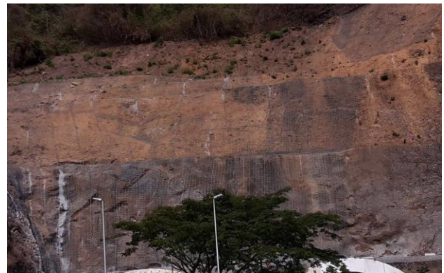
Figura 10. Bermas malla triple torsión.
