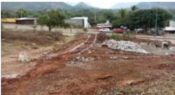
Fotografía No. 2. trazo del terreno a construir teniendo en cuenta los ejes de referencia
