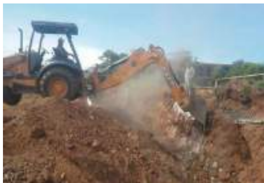
Fotografía No. 5 Excavación en terreno tipo B.
