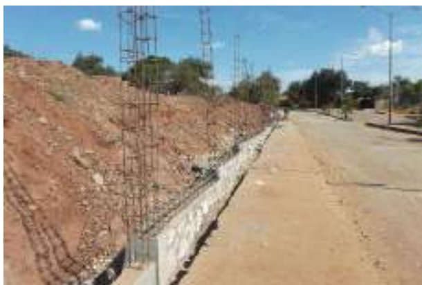
Fotografía No. 10 Armado y detallado de cadenas y castillos.
