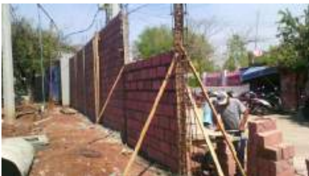
Fotografía No. 11 Alzado de muros de block macizo.
