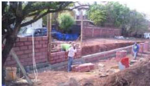
Fotografía No. 11 Alzado de muros de block macizo.
