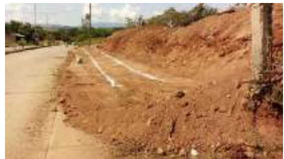
Fotografía No. 2. trazo del terreno a construir teniendo en cuenta los ejes de referencia
