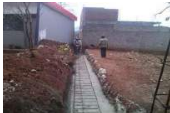
Fotografía No. 6 Plantilla para desplantar el murete de enrase.
