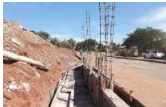
Fotografía No. 9 Colado de cadenas de desplante para el muro.
