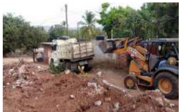
Fotografía No. 4 Acarreo de material producto de la demolición y excavación.
