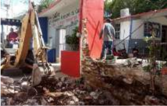
Fotografía No. 1 Demolición previa de elementos de concreto hidráulico y malla ciclónica existente
