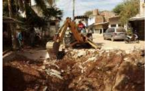
Fotografía No. 1 Demolición previa de elementos de concreto hidráulico y malla ciclónica existente
