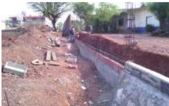
Fotografía No. 9 Colado de cadenas de desplante para el muro.
