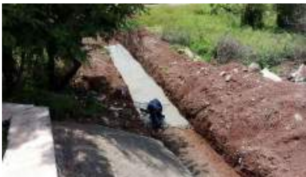
Fotografía No. 6 Plantilla para desplantar el murete de enrase.
