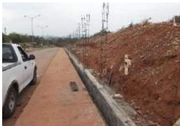
Fotografía No. 10 Armado y detallado de cadenas y castillos.
