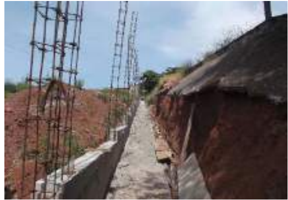
Fotografía No. 8 Murete de enrase para iniciar el muro.
