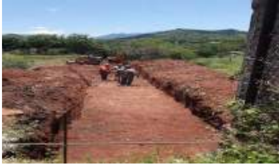
Fotografía No. 3. Nivelación del terreno a construir tomando en cuenta los ejes.
