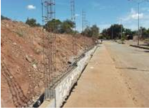
Fotografía No. 8 Murete de enrase para iniciar el muro.
