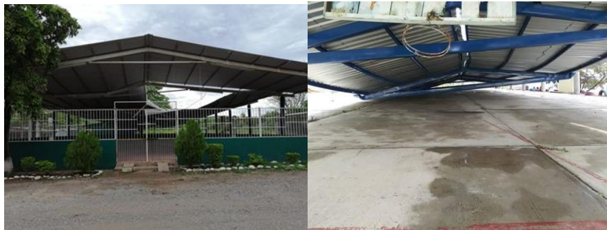
Figura 3. Colapso de estructuras tipo techumbres en plazas y escuelas (Guerrero, México).
