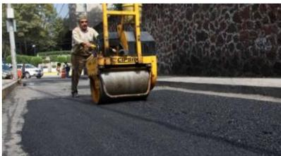
**Figura 7.** Compactación del concreto permeable con equipo menor
