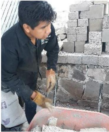
**Figura 10.** Obtención del agregado reciclado.
