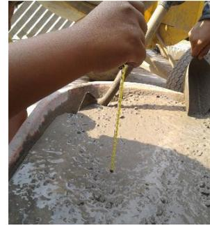
**Figura 21.** Registro de temperatura de concreto en estado fresco.
