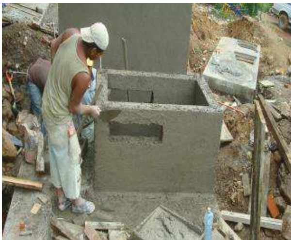
Figura 2. Aplanado o repellido con mortero.
