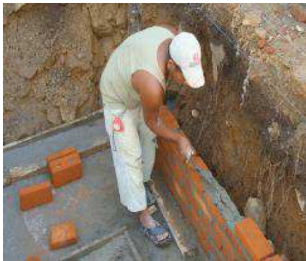
Figura 1. Junteo o pegado de mampostería.
