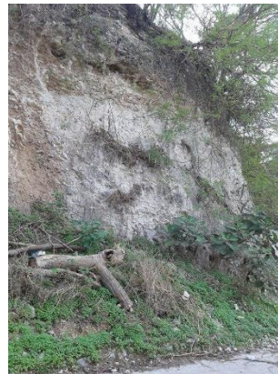
Fotografía 1: Estratigrafía de la ladera 1
