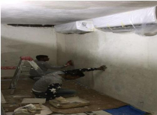
**Figura 17: Aplanado y colocación de pintura en los muros**
