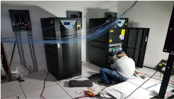
**Figura 10: Sistema de Energía Ininterrumpible (UPS).**
