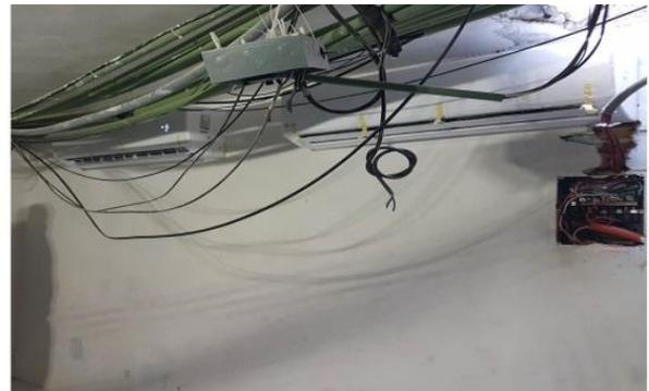
**Figura 11: Evaporadores en el interior.**
