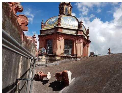
FIGURA 7. Rehabilitación de daños.
